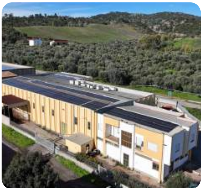
Impianto fotovoltaico, 50 kWp, Mandatoriccio (CS)
