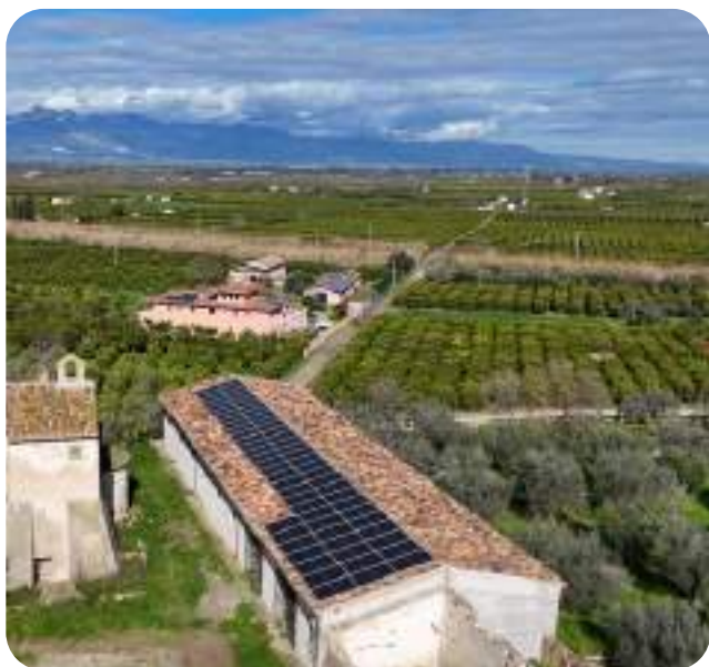
Impianto fotovoltaico, 31,52 kWp, Corigliano (CS)
