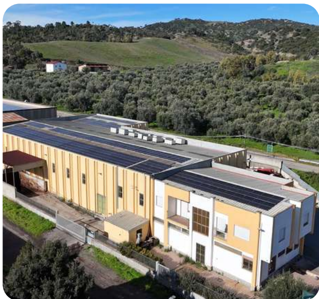
Impianto fotovoltaico, 50 kWp, Mandatoriccio (CS)
